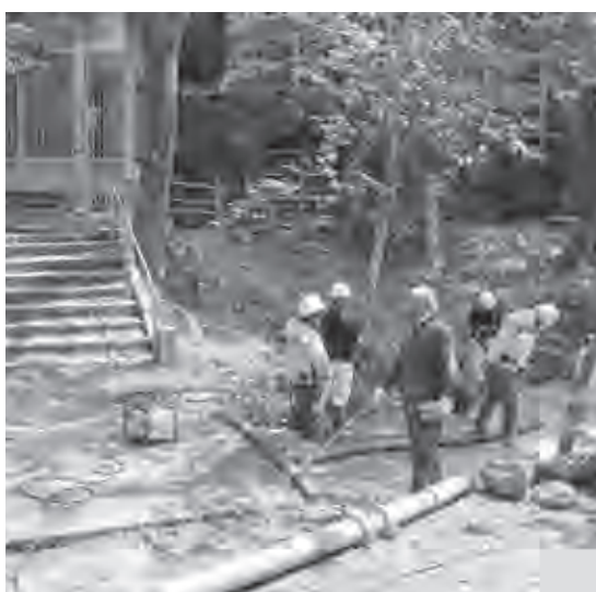
弁天池改修工事
